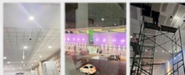
Sustitución de plafones y piezas de luminaria
